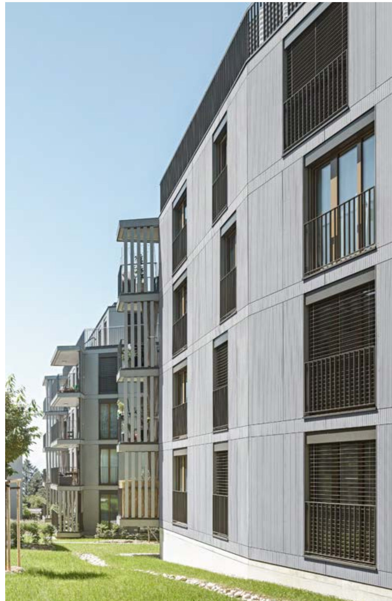
Fiches Nord, Lausanne, Švýcarsko. Architekt: Züst Gübeli Gambetti Architektur und Städtebau AG, Curych, Švýcarsko. Autor fotografie: Roger Frei, Curych, Švýcarsko.
