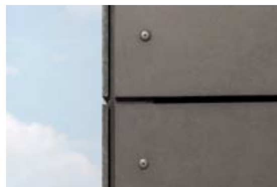
Viditelné ukotvení vláknocementových desek s použitím barevných nýtů
