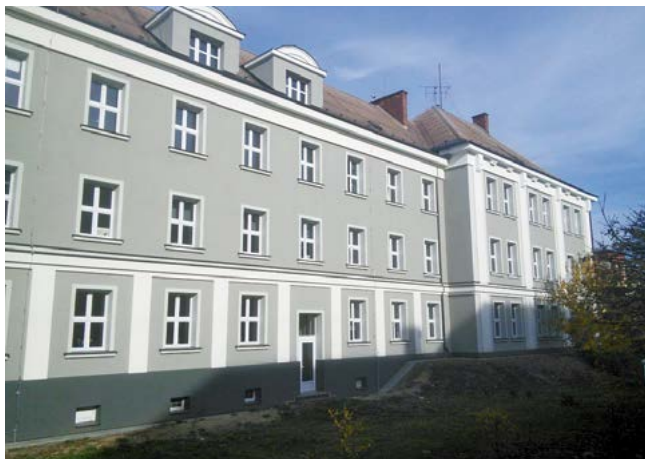
Zateplení školy v Českém Těšíně. Celkem se zateplovala plocha o rozloze 4 000 m 2 .
