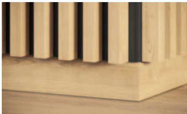
ukázka ukončení dekoračního panelu nad podlahovou lištou
