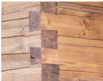
Roubenka tl. 200 mm > nahrazuje 40 mm tepelné izolace
