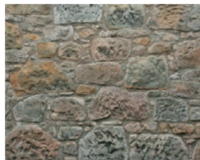
Kamenné zdivo 450 mm > nahrazuje 5 mm tepelné izolace
