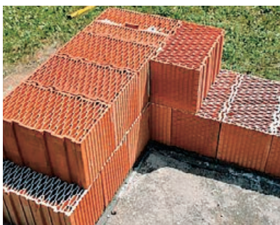
Therm bloky 450 mm > nahrazuje 100 mm tepelné izolace
