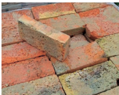
Plné cihly 450 mm > nahrazuje 20 mm tepelné izolace
