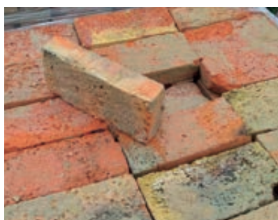
Plné cihly 450 mm > nahrazuje 20 mm tepelné izolace
