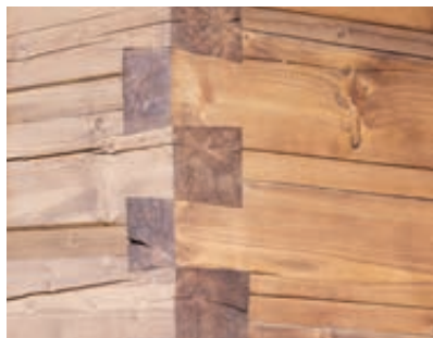
Roubenka tl. 200 mm > nahrazuje 40 mm tepelné izolace
