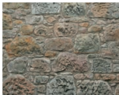
Kamenné zdivo 450 mm > nahrazuje 5 mm tepelné izolace
