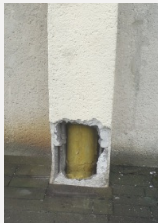
Z realizace vložkování SANATEC s izolací
