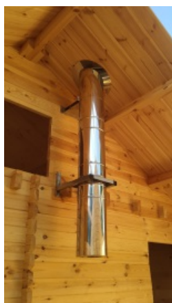
Příklad založení svislého kouřovodu
