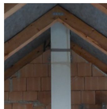
Přiběžné kotvení stěnovým úchyttem
