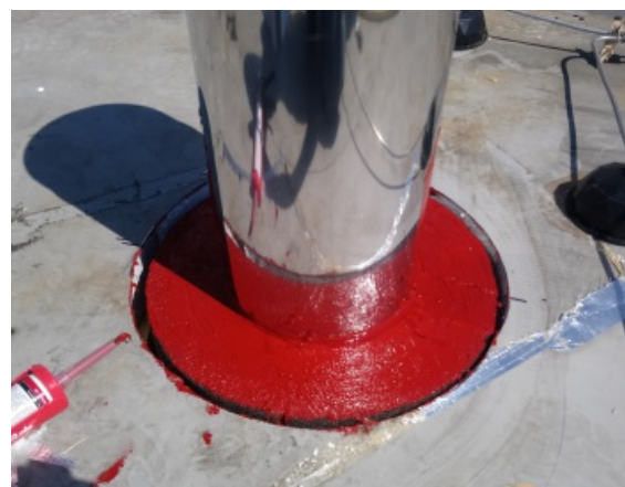
Komín v ploché střeše s instalovaným bezpečným prostupem
