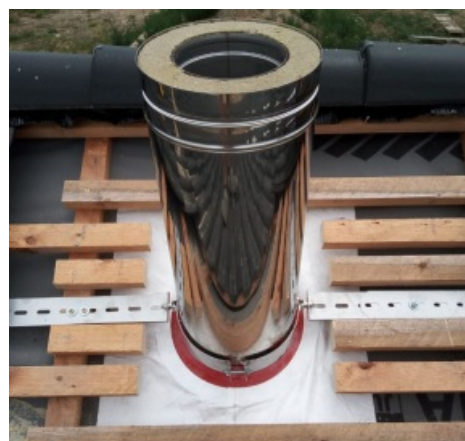
Využití těsnící manžety HotSchott a střešního držáku
