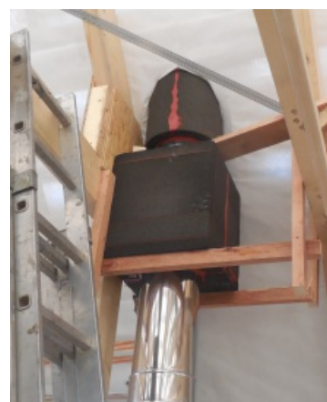
Parotěsné prostupy na nerezovém komíně
