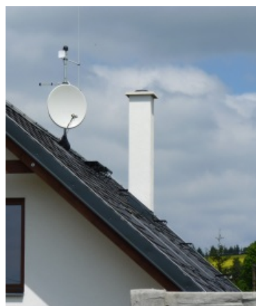
Omítnutá základní nadstřešní část
