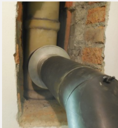
Napojení kouřovodu redukcí na izostatické vložky
