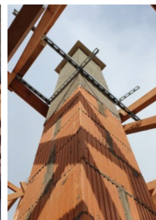
Kotvení komínu CIKO ke krovu
