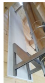
Založení na stěně
