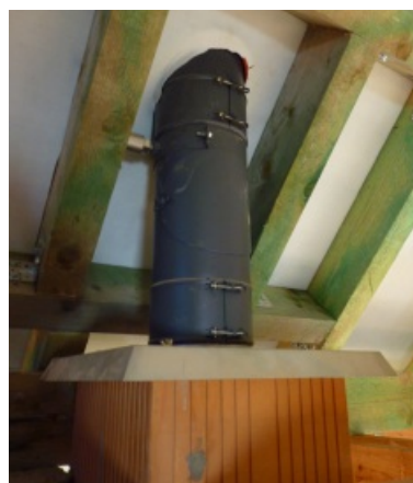
Nerezový nástavec založený pod střešou
