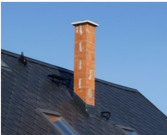
Základní nadstřešní část před finální úpravou
