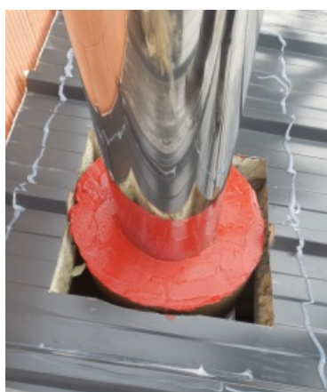
Parotěsný vstup zatřený záruvzdorným silikonem
