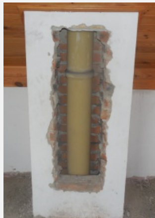
Z realizace vložkování SANATEC
