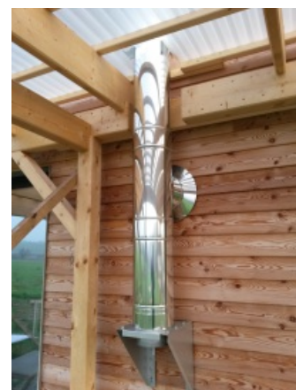
Nerezový komín založený na konzoli
