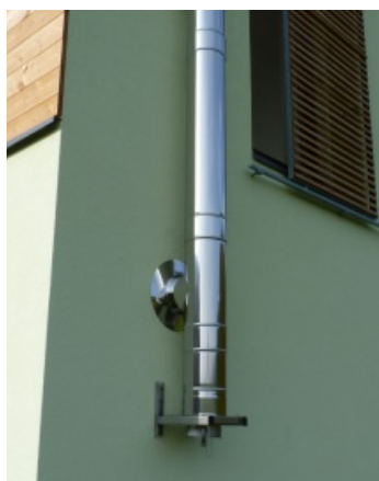
Fasádní komín na konzoli s čištěním spodem
