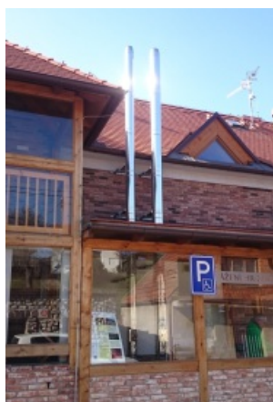
Novostavba s nerezovými komíny
