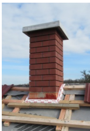
Bezpečný vstup komína střešní konstrukcí
