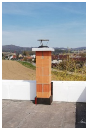
Parotěsný vstup plochou střechou
