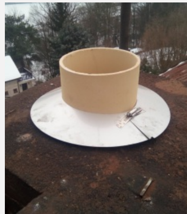
Ukončení nerezovým krycím límečem
