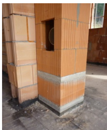
Přerušení tepelného mostu pod komínem
