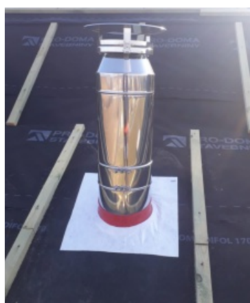
Manžeta HOTSchott nalepená k pojistné hydroizolaci
