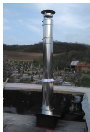
Prostup a vysoké lemování na ploché střeše
