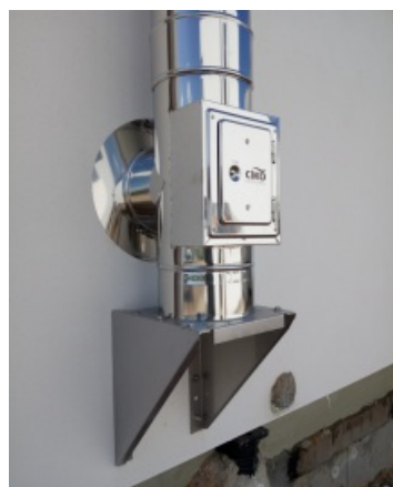
Fasádní komín na konzoli s dvířkovým dílem
