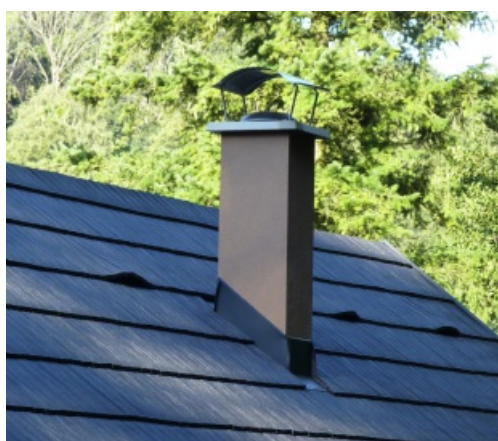
Omítnutý základ s oblou stříškou
