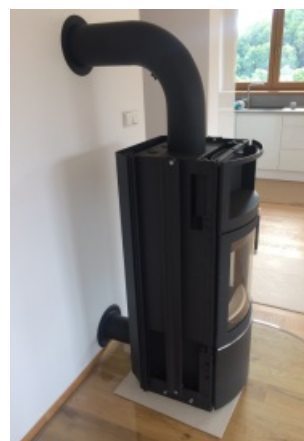
Napojení kamen na přívod vzduchu
