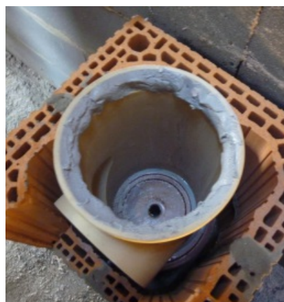
Spárovací hmota v hrdle vložky CIKO TEC
