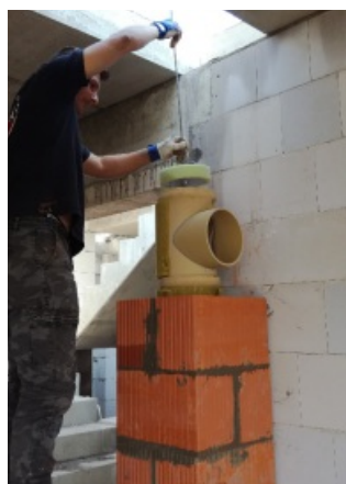
Čištění spojů CIKO TEC
