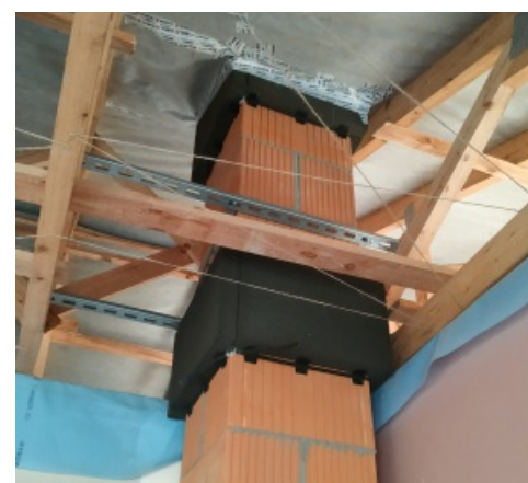
Parotěsné prostupy na cihelném komíně
