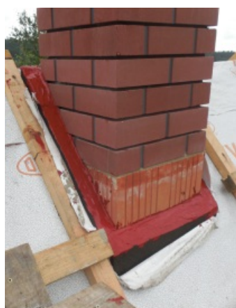
Parotěsný vstup cihelného komína
