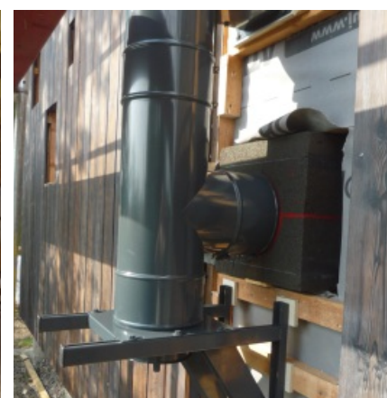
Parotěsný vstup kouřovodu
