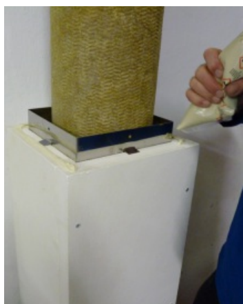
Slepování šachetních dílů COMPACT
