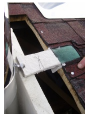
Příklad uchycení střešního držáku
