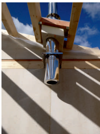
Systém Nerezo 3V kouřovod s funkcí komínu
