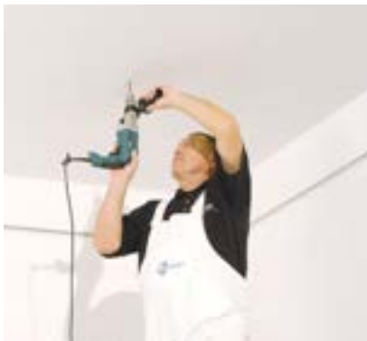
Kotvení závěsů do nosného stropu
