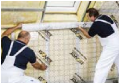
Instalace parozábrany – parozábrana na podkonstrukci
