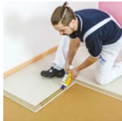
Nanesení podlahového polyuretanového lepidla
