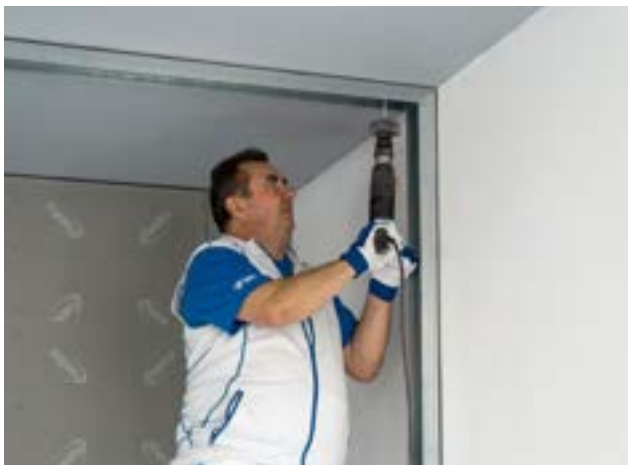
Montáž nosné konstrukce příčky – obvodové profily R-UW
