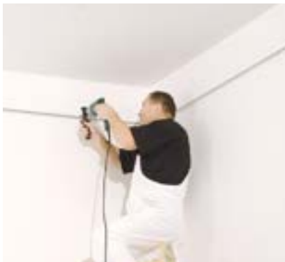
Montáž obvodových profilů
