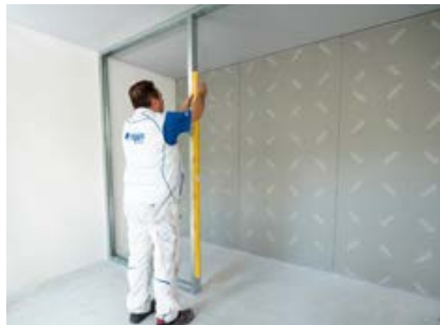
Montáž nosné konstrukce příčky – svislé profily R-CW
