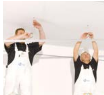
Osazení hlavních T-profilů
