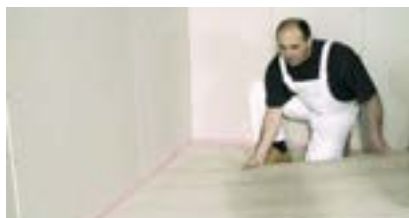
Pokládání druhé vrstvy desek
