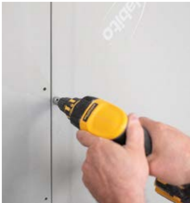
Montáž opláštění
