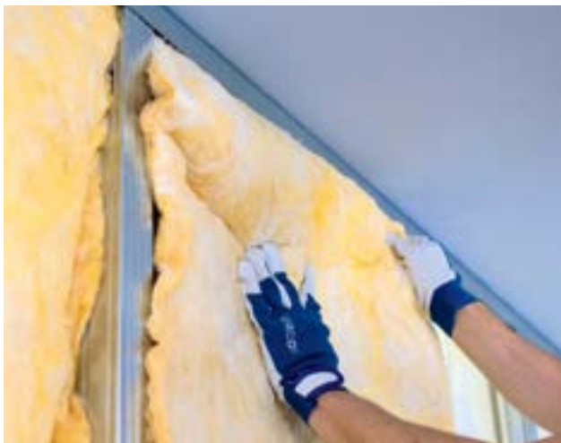
Vložení minerální izolace do dutiny příčky
