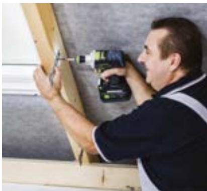
Přípevnění závěsů do dřevěných krokví
