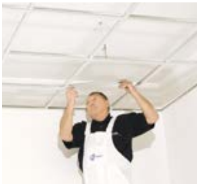
Osazení příčných profilů délky 600 mm
