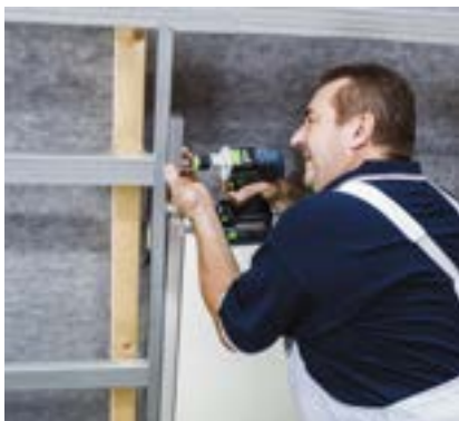
Vytvoření pomocné konstrukce z R-UD profilů včetně osazení R-CD profilů (zajištěny dvěma šrouby LB)
