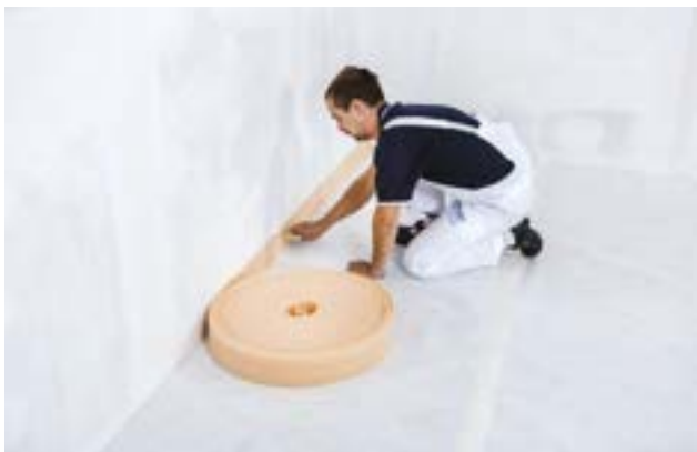
Aplikace obvodového pásku
