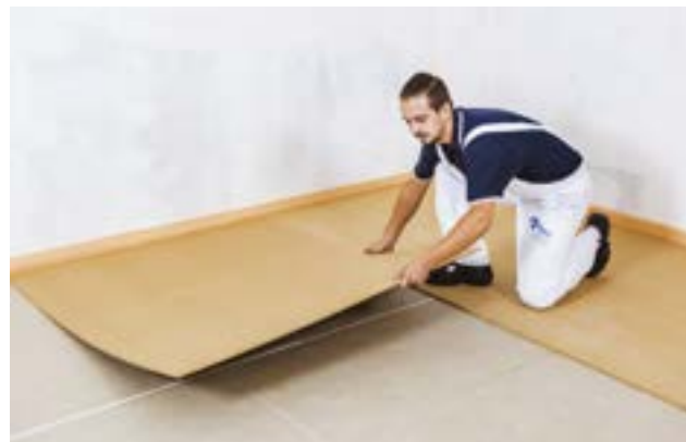
Pokládka izolantu (dřevovláknitých desek)
