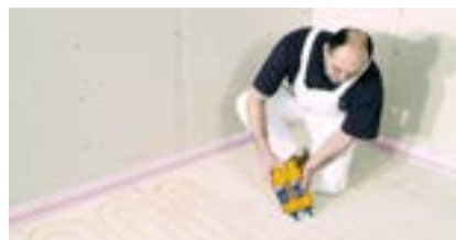
Nanášení lepidla v pruzích
