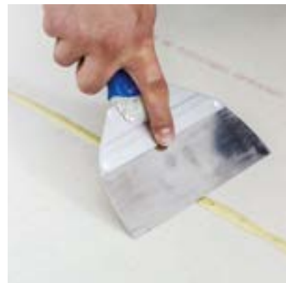
Stržení vypěněného polyuretanového lepidla
