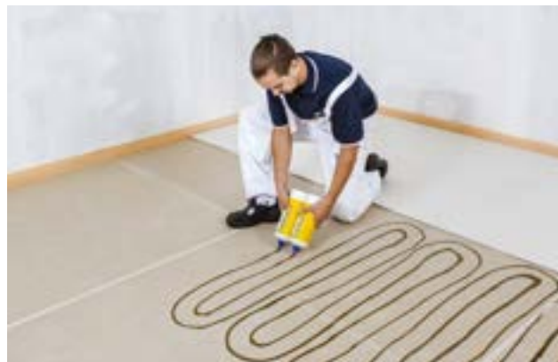
Prolepení desek podlahovým lepidlem Rigidur
