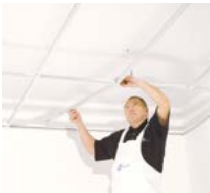
Osazení příčných profilů délky 1 200 mm
