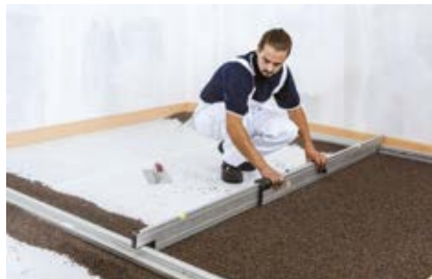
Výškové vyrovnání podsypu
