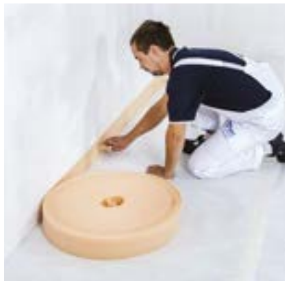
Přípevnění okrajových pásků
