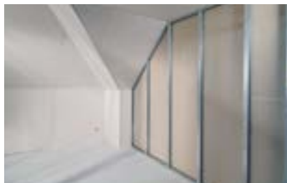
Opláštění příčky z jedné strany
