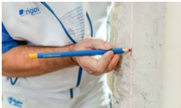
Vyměření příčky např. pomocí laseru
