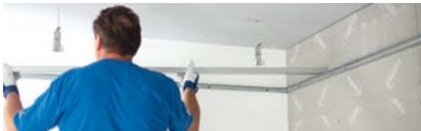
Osazení nosných R-CD profilů opláštění stropu
