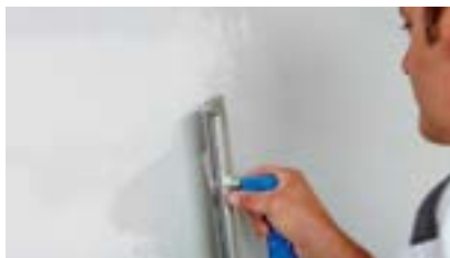
Rozažení a uhlazení tmelu
