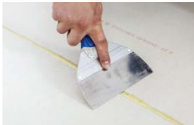
Seškrábnutí vypěněného polyuretanového lepidla
