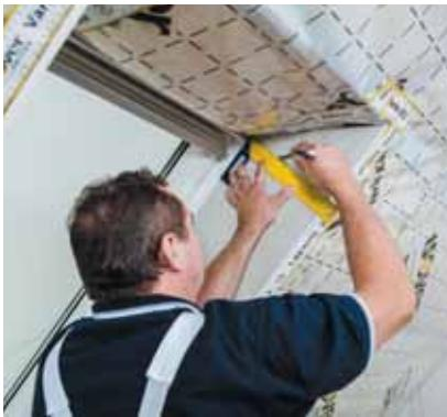
Rozměření zalomeného nadpraží a parapetu pomocí úhelníku...
