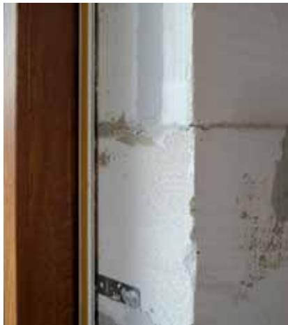
Na hrano okenního rámu se nalepí APU lišta. Kolmé špalety lze docílit tak, že nejdříve se nalepí APU lišta na okno a podle ní se potom osadí rohová lišta (doporučujeme pozinkovaný rohový profil). Chceme-li špaletu otevřenou, nejdříve se osadí rohová lišta proti okennímu rámu. Potom se nalepí APU lišta a o její tloušťku bude špaleta otevřená ve stejném úhlu na celém okně.
