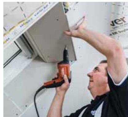
Zalomení nadpraží a parapetu provedeno naříznutím lícového kartonu a připevněno vrutem typu TN 25
