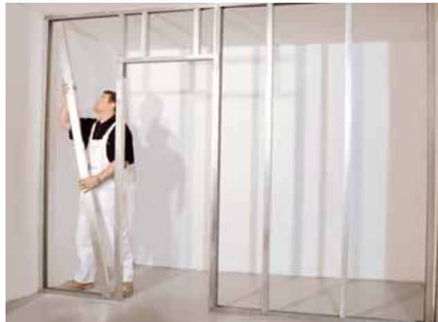
Montáž nosné konstrukce příčky – svislé profily R-CW
