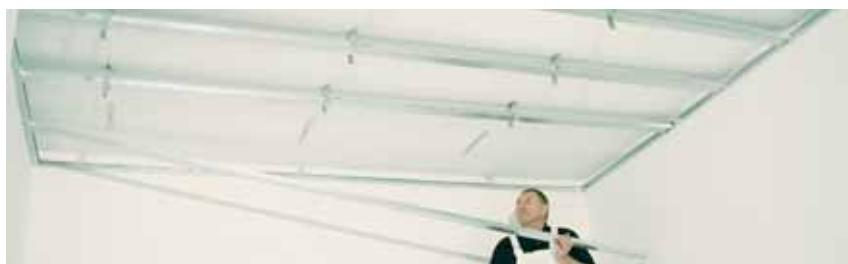
Osazení montážních R-CD profilů opláštění stropu
