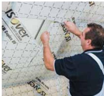
Aplikace parozábrany (v oblasti střešního okna parozábra proříznuta ve tvaru písmene „I“)
