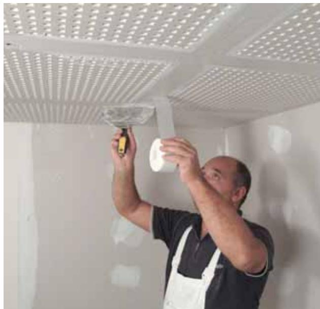
**TIP: Řešení napojení perforované oblasti desky na navazující svislou plochu:**
