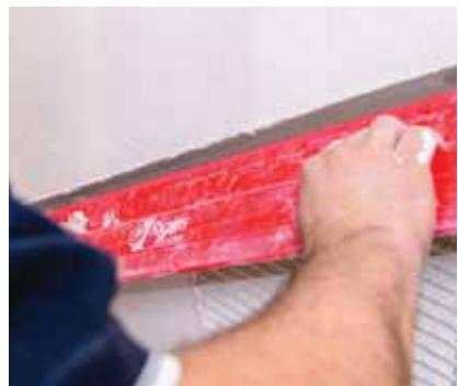
Následně se sádrová omítka (stěrka) vyhladí pomocí špachtli s dvojitým lisem (špachtle pro celoplošné tmelení Rigips) nebo fasádní špachtlí. Zde je nutné vést špachtli kolmo přes „zuby“ co nejvíce na plocho a mírně zešikma (je nutné dbát na to, aby nedocházelo ke zbytečnému odebírání materiálu). Vyhlazení se provádí tahy do kříže. Je potřeba vyvarovat se tahům do oblouku, při kterých se jen velmi těžko dosahuje rovinosti plochy.
