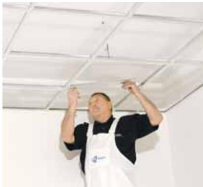
Osazení příčných profilů délky 600 mm
