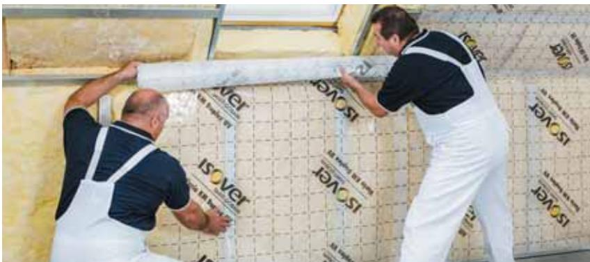
Instalace parozábrany – parozábrana na podkonstrukci
