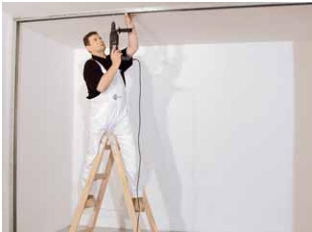
Montáž nosné konstrukce příčky – obvodové profily R-UW
