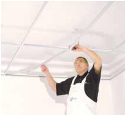
Osazení příčných profilů délky 1 200 mm
