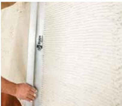
Srovnání nanesené vrstvy u sádrových omítek a stěrek se provádí stahovací latí se zuby pro sádrové omítky Rigips. „Zubová“ lat' zajistí rovnoramennou tloušťku sádrové omítky/stěrky, čímž se dosáhne lepší rovinnosti.
