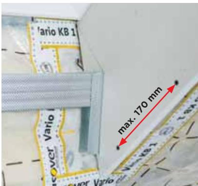
Stejné zásady pro montáž podkonstrukce nadpraží platí i pro parapet
