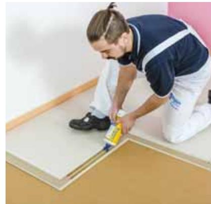
Nanesení podlahového polyuretanového lepidla
