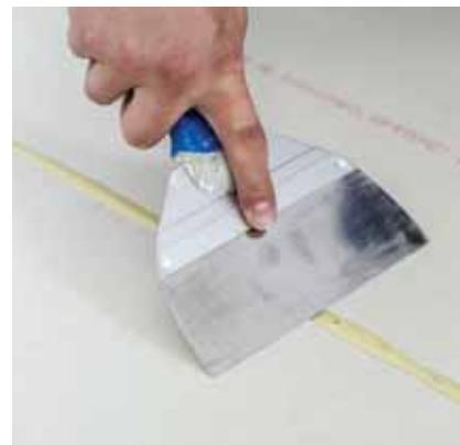
Stržení vypěněného polyuretanového lepidla
