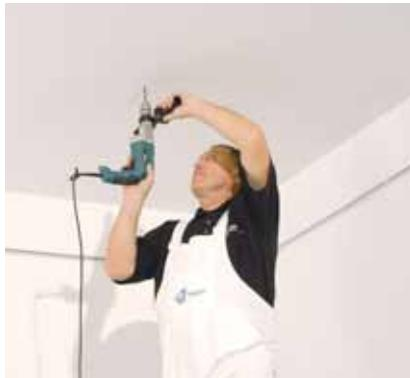
Kotvení závěsů do nosného stropu
