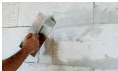
Větší spáry a díry ve zdivu (např. ulomené hrany zdíčích bloků) se nejprve vypraví sádrovou omítkou. Pokud se zapravují i drážky instalací nebo větší prohlubně, nechá se směs před vlastním omítáním stěny cca 2 hodiny ztuhnout.
