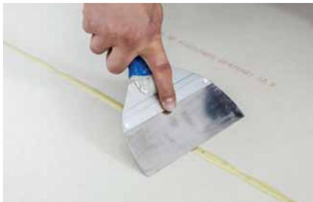
Seškrábnutí vypěněného polyuretanového lepidla
