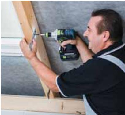
Připevnění závěsů do dřevěných krokví
