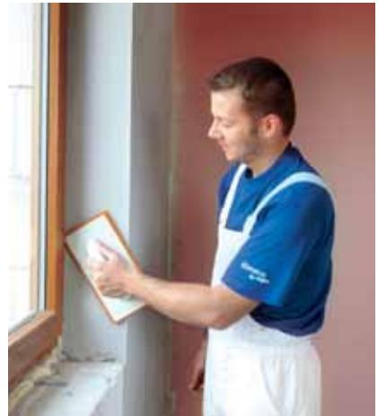
Do nanesené směsi se vloží rohová lišta a srovná se do tloušťky omítky na zdivu a na rovinu APU lišty na rámu okna. Oba profily je nutné osazovat s velkou pečlivostí s ohledem na svislost a rovinnost špalety.
