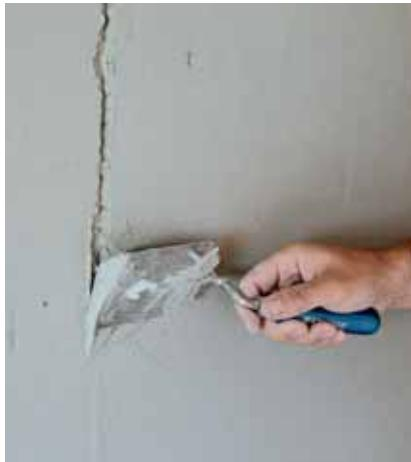
Po srovnání omítky „h“ latí (tedy hned po omítnutí pole mezi dvěma omítníky) je potřeba omítníky vyjmout ze stěny. Drážka po omítníku se zapraví směsí pokud možno ze stejného míchání jako směs na stěně.
