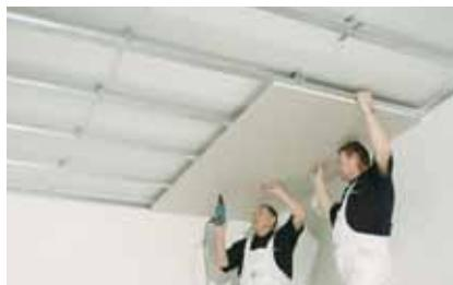
V případě, kdy není třeba zajistit dilatační nezávislost podhledu na okolních vertikálních konstrukcích (do plochy podhledu cca 30 m<sup>2</sup>), lze opláštění šroubovat i do obvodových R-UD profilů. Desky se orientují vždy délkom kolmo k montážním profilům. Příčné spáry sousedních desek musí být vystřídány (přesazeny) minimálně o jeden montážní profil, aby nedocházelo k vytváření křížových spár.
