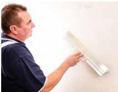
Lžící nebo škrabkou pak odstranit případné výčnělky, nesoudržná místa, povrchové nečistoty (cementové mléko, zbytky zdicí malty apod.).
