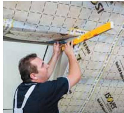
... a vodováhy (deska do drážky rámu je vsazena nasucho a dočasně připevněna vrutem TN 25 mm)
