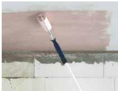
**Sklovitě hladké podklady** (např. monolitické konstrukce z betonu) se opatří **Základním kontaktním nátěrem Rigips** pro zvýšení přídržnosti omítky k podkladu. Kontaktní nátěr je třeba před vlastní aplikací, a stejně tak i v průběhu aplikace, dobře promíchat. Tím se zamezí usazování hrubších složek disperze na dně kbelíku. Kontaktní nátěr se aplikuje výhradně válečkem. Potřebná doba k vyzráni kontaktních i penetračních nátěrů před aplikací sádrových omíttek a stěrek Rigips je min. 24 hodin.
