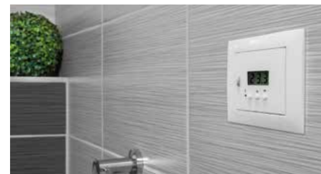
Ukázka interiérového ovladače se zabudovanými čidly prostorové a podlahové teploty s LCD displejem (dle designu investora)
