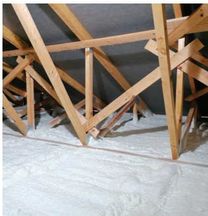
Nástřik shora (z půdního prostoru) do vazníkové konstrukce na OSB desku
