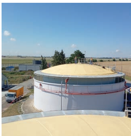
Aplikace izolace na skladovací nádrži (ocelový plech)
