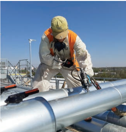
Izolace potrubí - litím PUR pěny „plnicími otvory“
