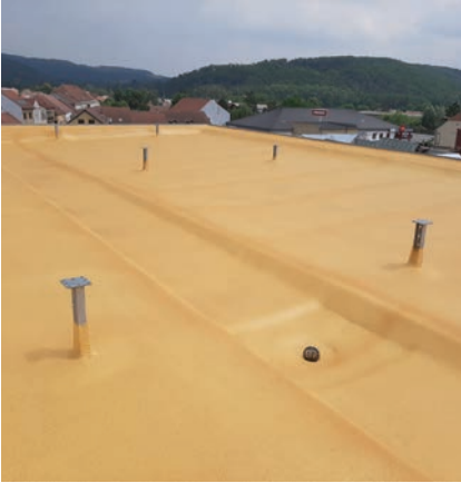
Střecha po nástřiku pěnou PUR
