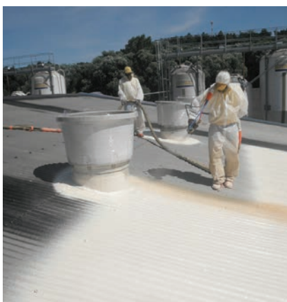
Nástřik izolace střechy živočišné výroby (hliníkový plech)
