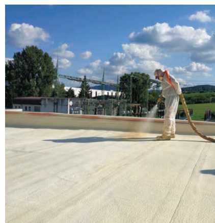
Nástřik izolace střechy průmyslové haly (asfaltové pásy)
