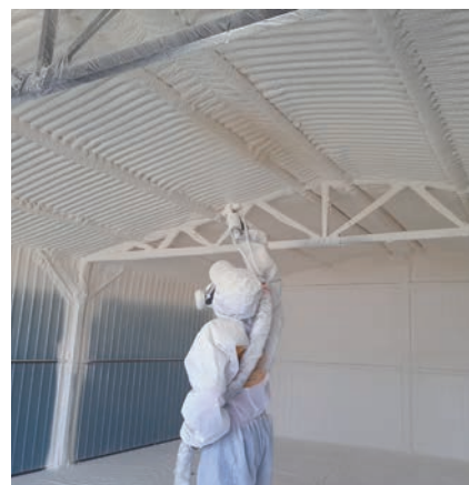
Zaizolování ocelové garáže proti kondenzaci
