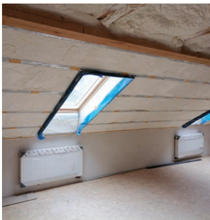
Nástřik podkroví na kontaktní difuzní vrstvu
