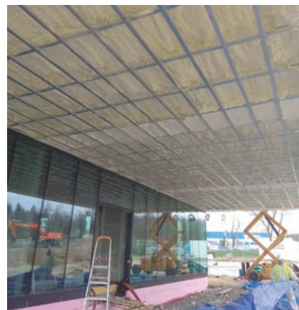
Zateplení podhledu betonového stropu
