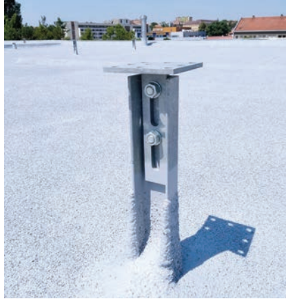
Finální řešení kritického detailu nosné patky
