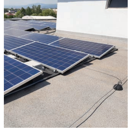
Přitížená konstrukce FVE pomocí betonových prvků
