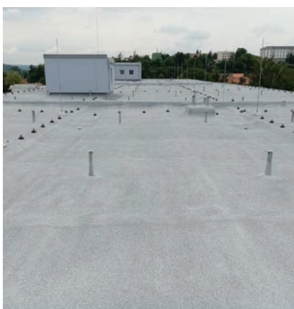
Izolace střechy v kombinaci s polystyrenem (asfaltové pásy)
