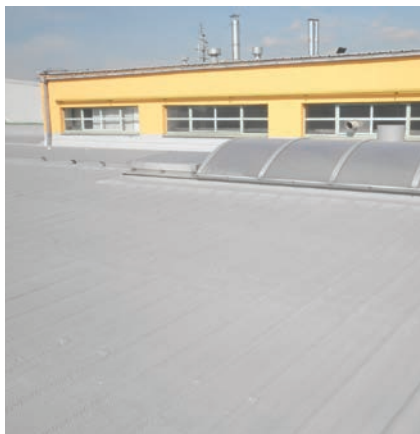
Izolace střechy (trapezový plech)
