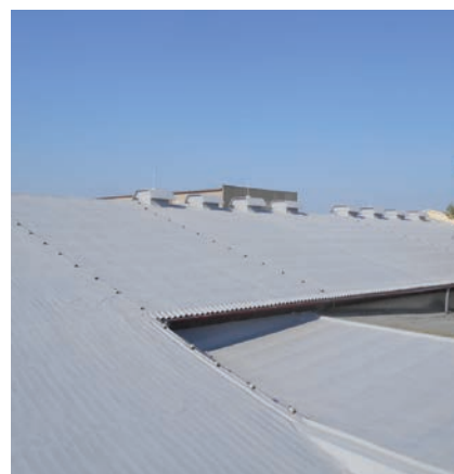
Izolace střechy skladovací haly (eternit)
