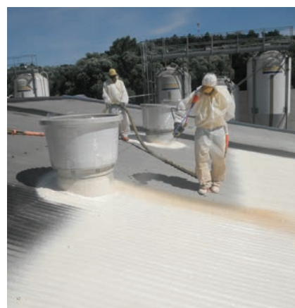
Nástřik izolace střechy živočišné výroby (hliníkový plech)
