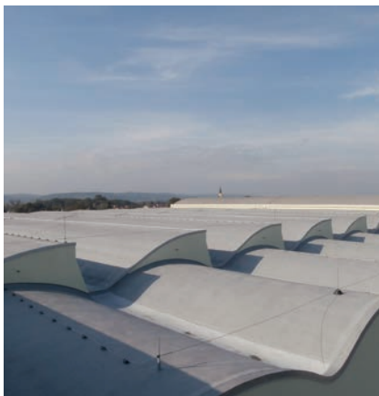
Izolace shedových střech (asfaltové pásy)
