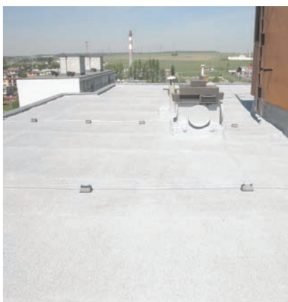
Izolace střechy panelového domu (asfaltové pásy)
