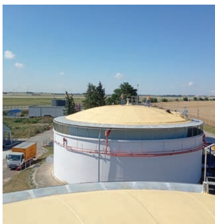
Aplikace izolace na skladovací nádři (ocelový plech)
