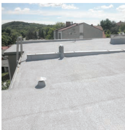
Izolace střechy na rodinném dvojdomek (asfaltové pásy)
