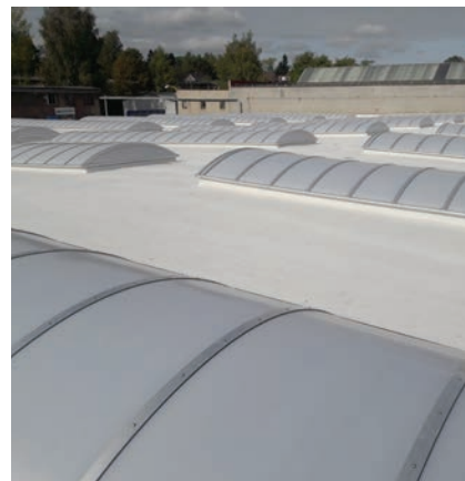
Izolace střechy se světlíky (asfaltové pásy)
