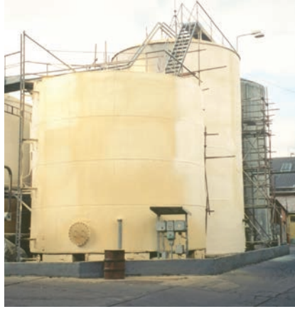
Izolace vnějšího opláštění nádrže „typ Vítkovice“
