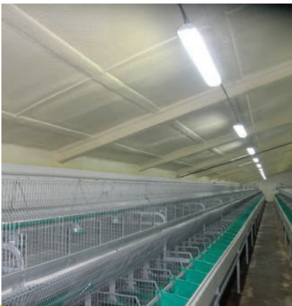
Izolace stropní konstrukce na odchovu králíků
