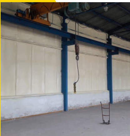
Zateplení stěny na průmyslovém objektu
