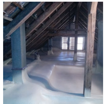
Zateplení podlahy půdního prostoru pochozí pěnou
