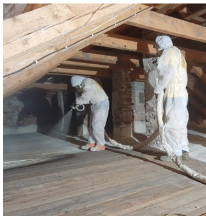
Zaizolování posledního stropu pochozí pěnou
