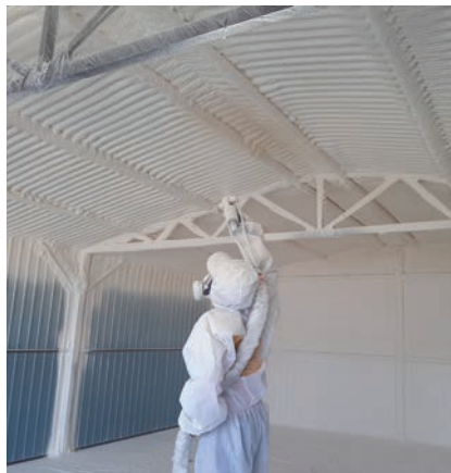
Zaizolování ocelové garáže proti kondenzaci
