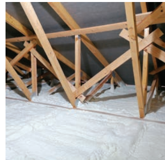
Nástřik shora (z půdního prostoru) do vazníkové konstrukce na OSB desku (před a po nástřiku)
