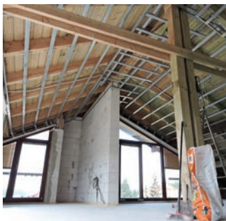
Nástřik do hřebene na dřevěné bednění (před a po nástřiku)
