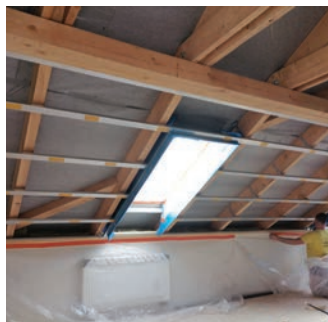
Nástřik podkroví na kontaktní difúzní vrstvu (před a po nástřiku)
