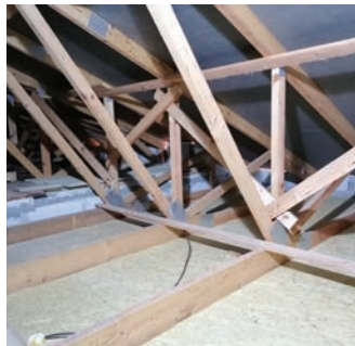
Nástřik shora (z půdního prostoru) do vazníkové konstrukce na OSB desku (před a po nástřiku)
