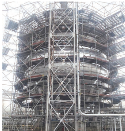
Izolace kulového zásobníku
