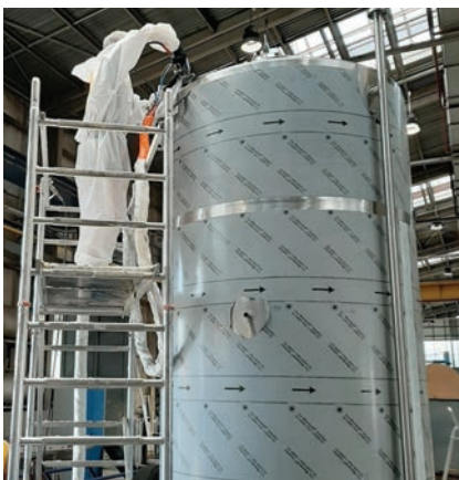
Izolace nádrže - lití PUR pěny „plnicími otvory“
