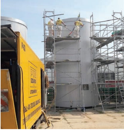
Provádění izolace tanku na pivo
