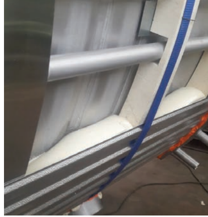
Detail izolace – lití PUR pěny „za oplechování“
