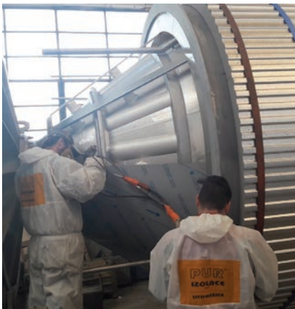
Detail izolace kónusu CKT tanku na pivo
