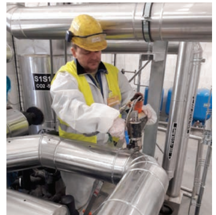
Izolace potrubí – litím PUR pěny „plnicími otvory“
