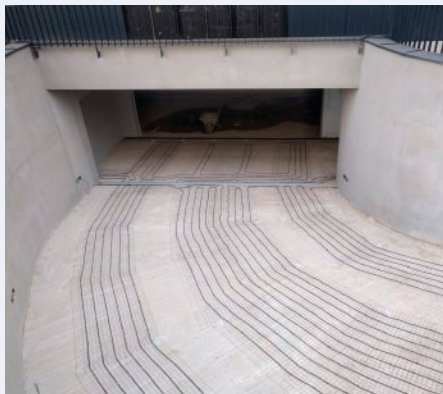
Vjezd do podzemní garáže, Záhřeb, Chorvatsko
